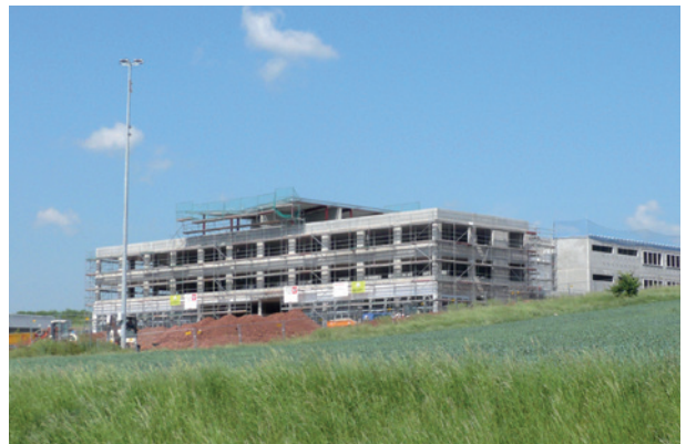
Mobotix AG Firmengebäude, Kaiserslautern ExtruPol Dachabdichtung, 6.000 m²
