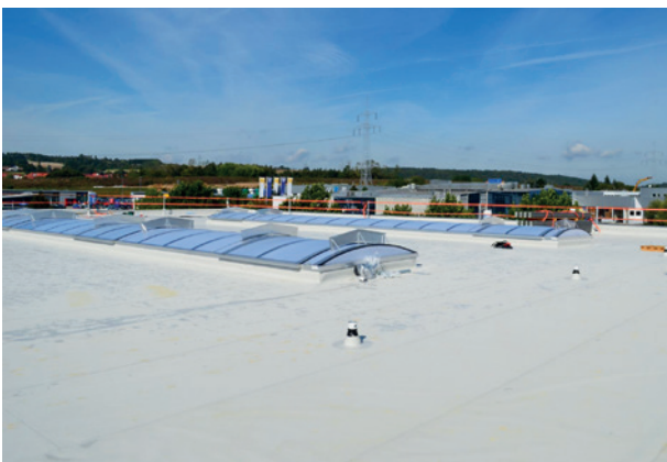
Sartorius AG, Göttingen ExtruPol Dachabdichtung 2.300 m 2
