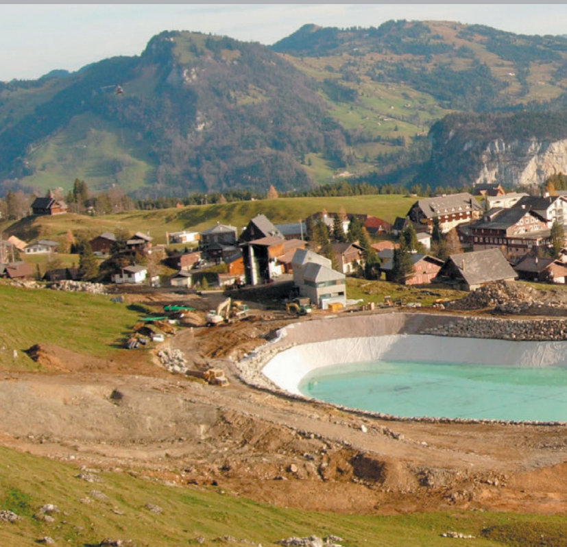
Speichersee Stoons, Schweiz ExtruPol, 8.500 m 2
