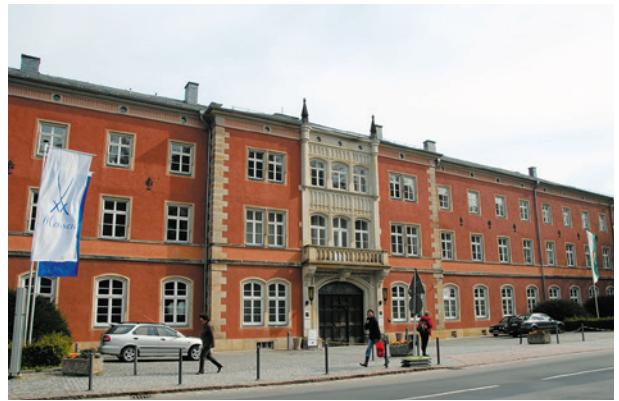
Produktionshalle Porzellanmanufaktur Meissen, Meißen ExtruPol Dachabdichtung, 2.500 m²
