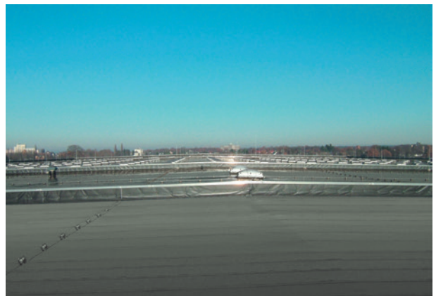
H&N-Versandlager, Hann. Münden, ExtruBit Dachabdichtung, 11.000 m 2
