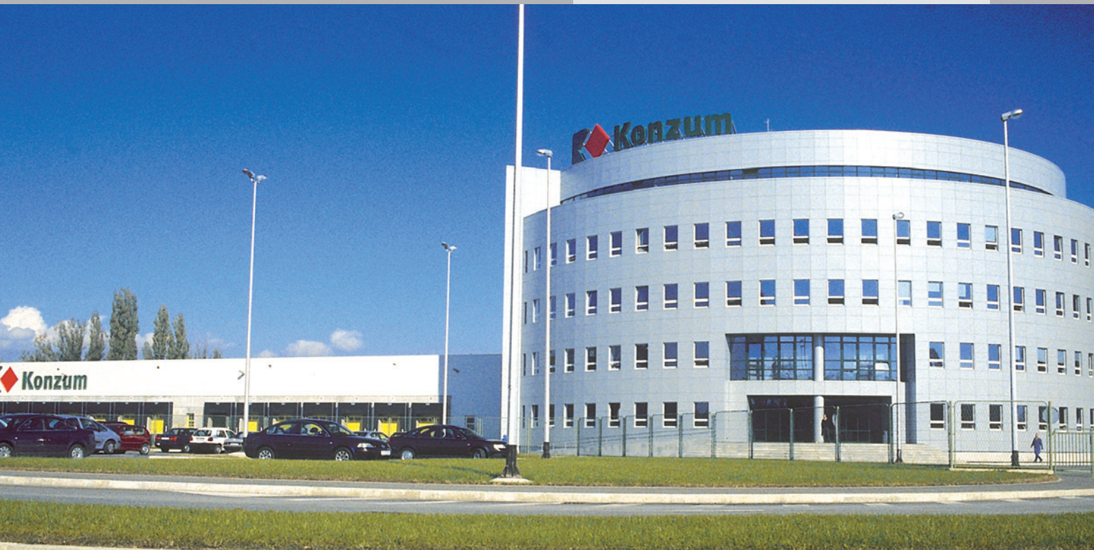
Konzum Zagreb/Kroatien ExtruBit Dachabdichtung, 25.000 m 2
