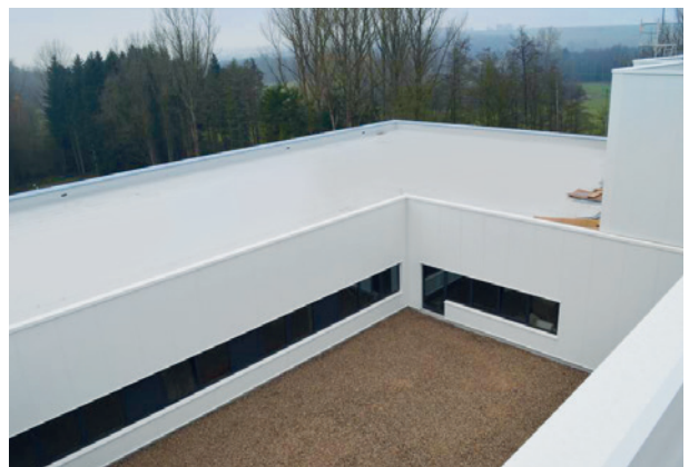
Infineon Warstein, ExtruPol Dachabdichtung, 3.500 m 2
