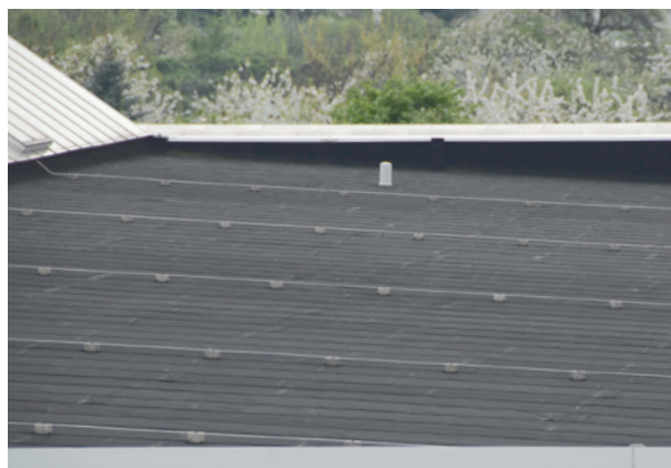
Dresdner Verkehrsbetriebe AG, Dresden, Dachabdichtung ExtruBit 10.000 m 2 und ExtruPol 6.000m 2
