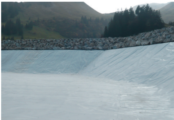
Speichersee Stoons, Schweiz, ExtruPol, 8.500 m 2
