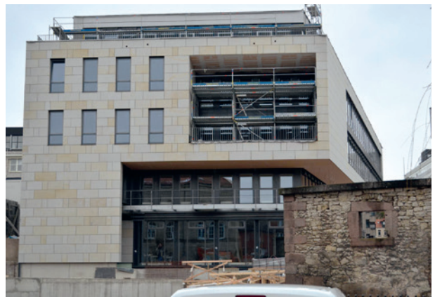
Quartier am Leinebogen, Göttingen ExtruPol Dachabdichtung 2.000 m 2
