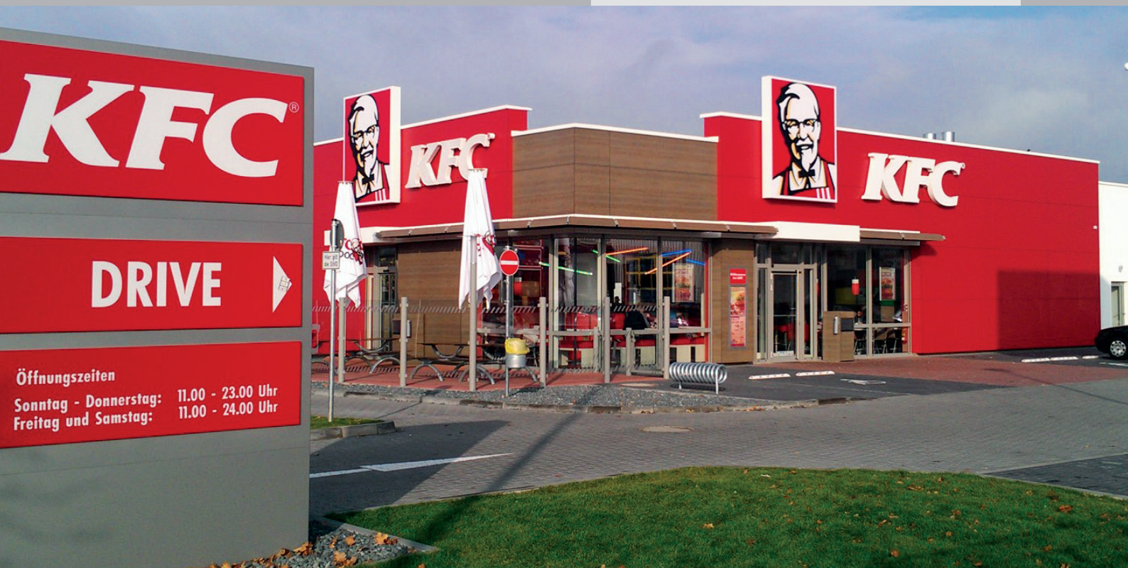
KFC Schnellrestaurant, Göttingen ExtruPol Dachabdichtung, 500 m 2
