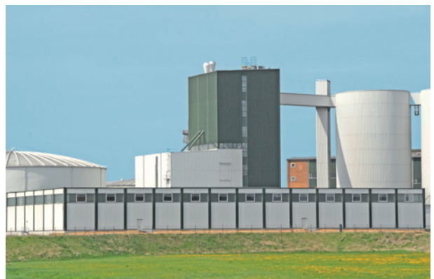
Südzucker AG, Mannheim, ExtruPol Dachabdichtung,, 4.000 m²
