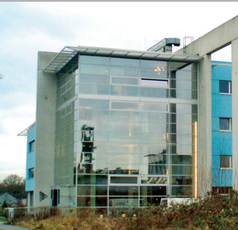
Bürogebäude, Bochum ExtruBit Dachabdichtung, 2.500 m 2
