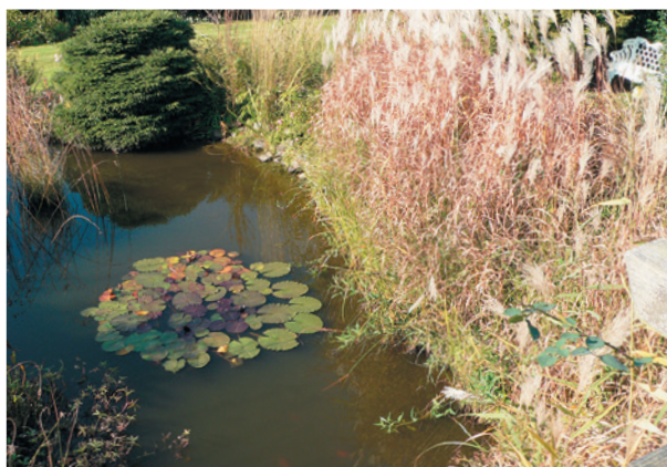
Porta Westfalica, ExtruBit Teichabdichtung, 80 m 2
