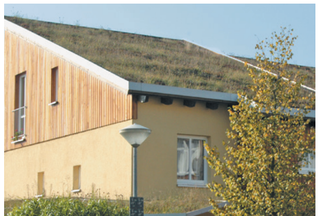
Gründach-Siedlung Bovenden, ExtruBit Dachabdichtung, 850 m 2
