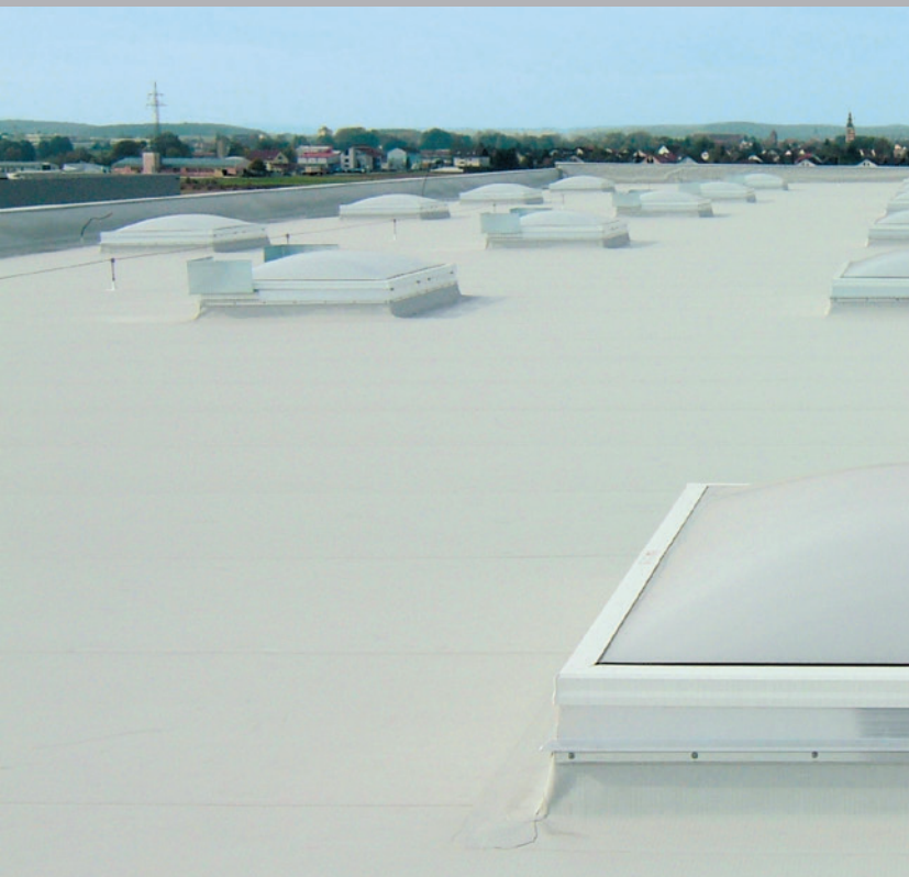
Lekkerland, Höchststadt ExtruPol Dachabdichtung, 11.000 m 2
