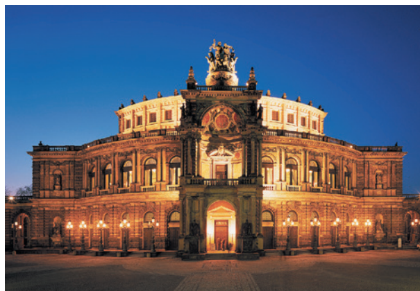
Semper Oper Dresden, ExtruBit Dachabdichtung, 1.800 m 2
