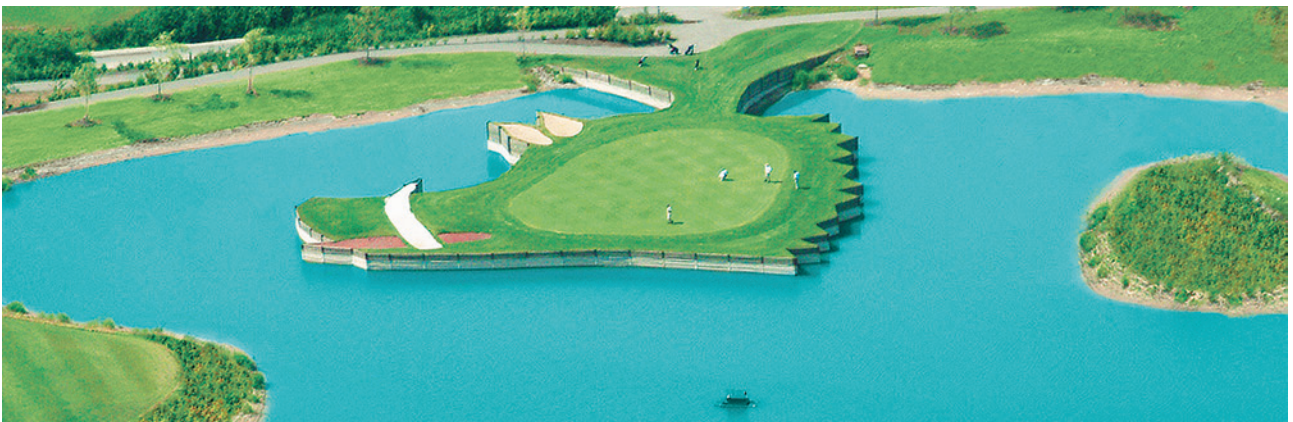
Golfclub Hardenberg e. V., Gut Levershausen, ExtruPol Basisabdichtung, 1.400 m 2
