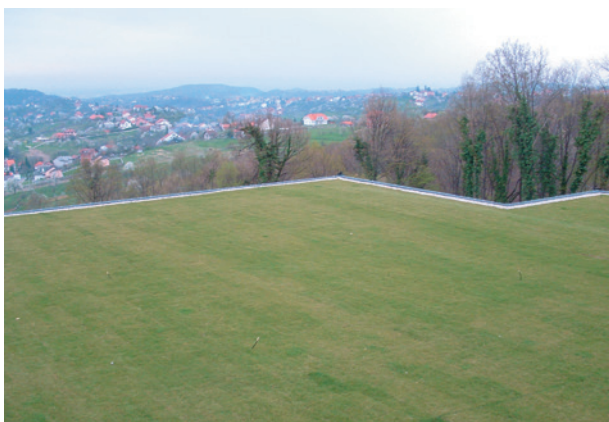
Dachbegrünung Hotel Kulmer, Zagreb/Kroatien ExtruBit Dachabdichtung, 1.000 m 2
