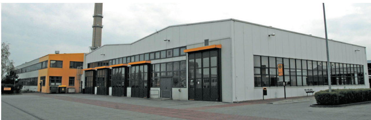
DVB Dresdner Verkehrsbetriebe AG, ExtruBit Dachabdichtung, 10.000 m 2 ; ExtruPol Dachabdichtung, 4.000 m 2
