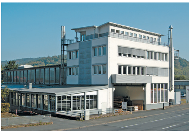
HTT, Hann. Münden ExtruPol Dachabdichtung, 4.000 m 2
