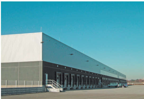
Lidl Logistikzentrum, Leverkusen, ExtruBit Dachabdichtung, 33.000 m 2
