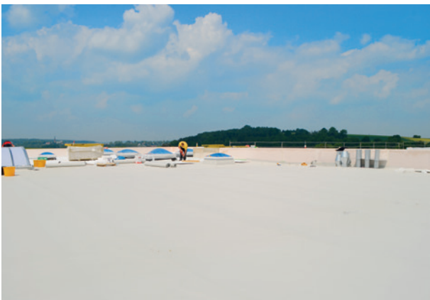
Autohaus, Burgwald ExtruPol Dachabdichtung 1.800 m 2
