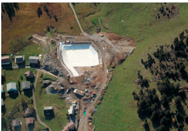
Speichersee Stoons, Schweiz, ExtruPol, 8.500 m 2
