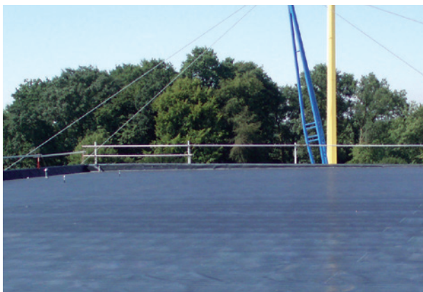
Eissporthalle, Greifath, ExtruBit Dachabdichtung, 4.000 m 2
