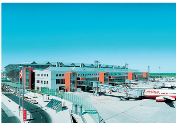
Flughafen Dresden ExtruPol Dachabdichtung, 6.350 m 2
