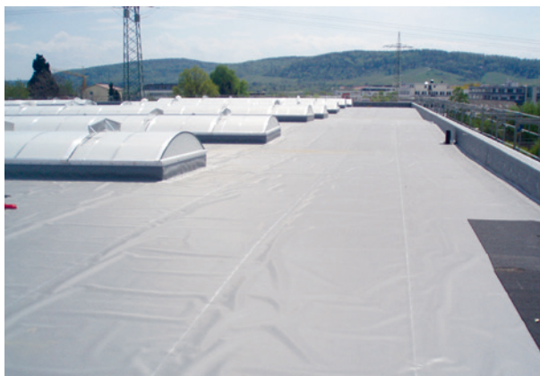
Kälte-Logistikzentrum Fischer GmbH, Felbach ExtruPol Dachabdichtung, 4.200 m 2
