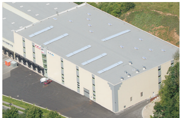
Pufas, Hann. Münden, ExtruPol Dachabdichtung, 7.100 m²
