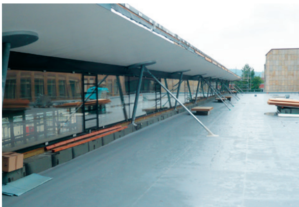
Neue Universitäts-Mensa, Bamberg, ExtruPol Dachabdichtung, 1.500 m 2 (Verleger: WDA Wickmann, Chemnitz)
